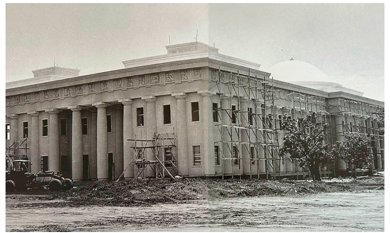
El Palacio de Bellas Artes durante su construcción.
